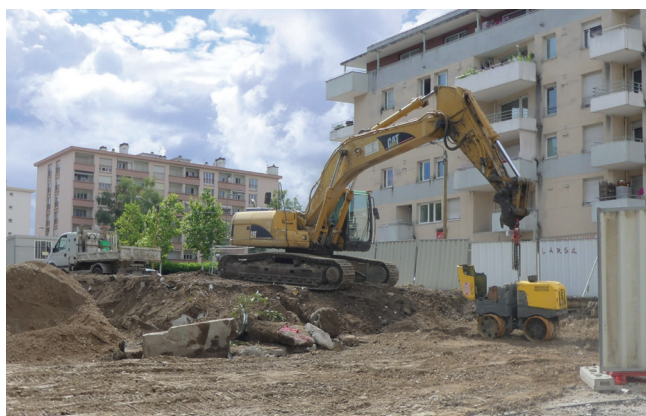
Démolition d'une boulangerie, 102 rue de Genève Juillet 2017
