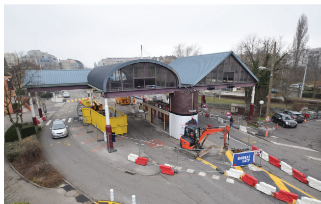
Démolition d'une aubette, douane de Moillesulaz Janvier 2017
