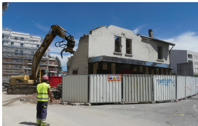
Démolition d'un pub, 22 rue de la zone Juillet 2017
