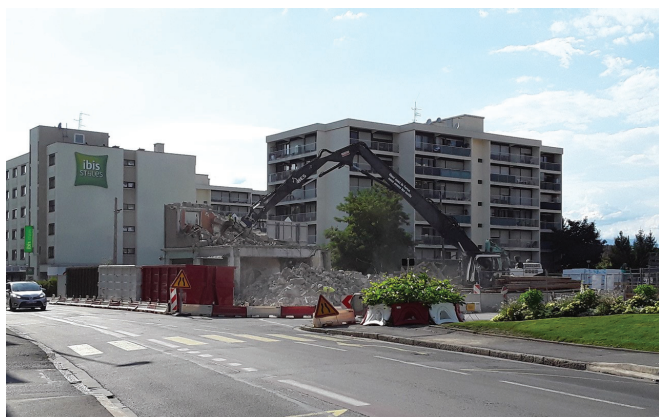
Démolition d'un coiffeur, 2 rue de Genève Juillet 2017
